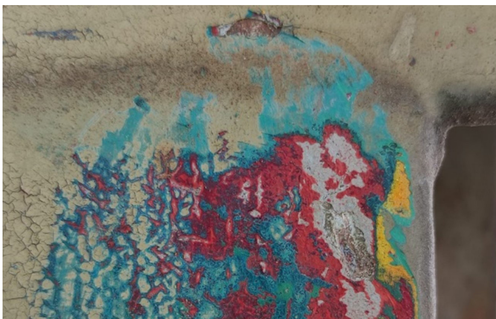
Figura 18 Janela de amostragem das diferentes camadas cromáticas existentes nas caixilharias originais das janelas durante a intervenção Fonte: ERA Arqueologia, 2022
