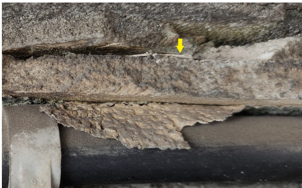
Figura 17 Camada monocromática presente debaixo do vão de janela do r/c durante a intervenção Fonte: ERA Arqueologia, 2022
